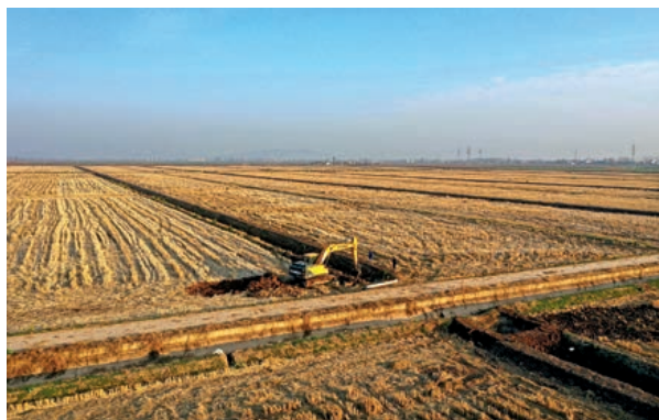
1月18日，位于安徽省宿松县的农垦华阳河农场第三农业分公司，挖掘机给稻田筑埂、开沟，为春季放养小龙虾做准备。图/中新社发 李龙 摄
